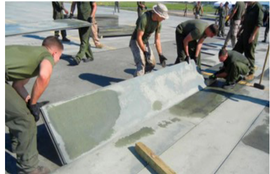
Рисунок 6. ПРИМЕНЕНИЕ МЕТАЛЛИЧЕСКИХ ПЛАСТИН В ПРОЦЕССЕ ПОДГОТОВКИ АЭРОДРОМА 10
